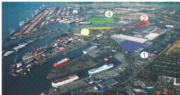
Abb. 1: Luftbild des Überseehafens mit ausgewählten PKW-Stellflächen
