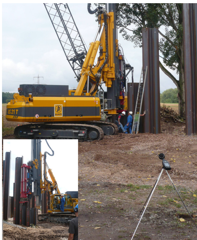
Abb. 10: Photographie der Aufbaus des Schallpegelmessers im Bereich der Rammfläche 1 in einem Abstand von 22,80 m zur Schlagramme (Photos: BfG, M1, S. Mai)
