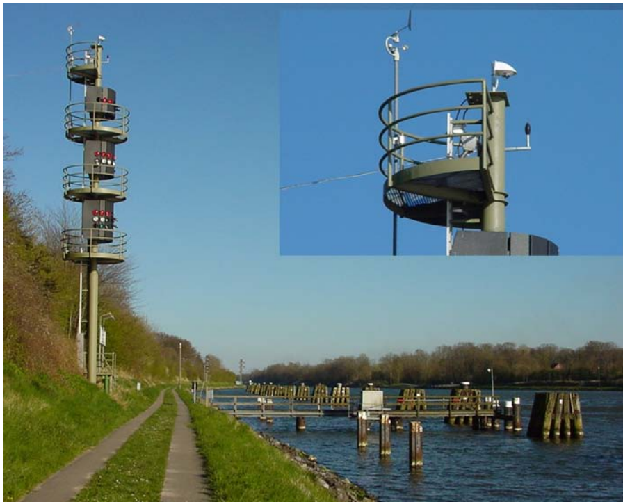
Abb. 2: Photographie der Installation des Außenmikrophons und der Digitalkamera an der Signalanlage der Weiche Königsförde (Photos: BfG, M1, D. Lippert)
